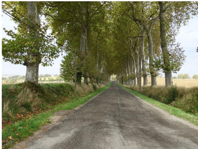
Allée de platanes en Haute-Garonne. Bien que plantés en crête de talus, la dénivelée étant faible, de même que l'écart à la voie, la relation avec la route reste étroite et la colonnade perceptible : allée protégée
