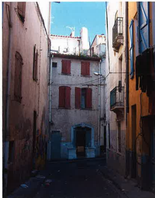
Site patrimonial remarquable de Perpignan (Pyrénées-Orientales) avec, au second plan, une maison médiévale à boutique proposée à la démolition pour prolonger la rue des Mercadiers dans le cadre du NPNRU. Projet bloqué par l'ABF conformément aux dispositions du site patrimonial remarquable (PSMV). L'ABF serait privé de ce pouvoir d'avis par la Loi ÉLAN en cas de projets de l'ANAH ou de l'ANRU.
