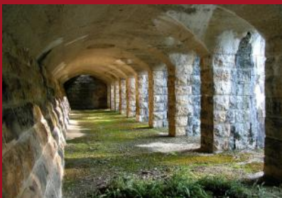
rieur, permette de palier aux crues éventuelles. Ils sont constitué de 11 voûtes et 10 piliers.
