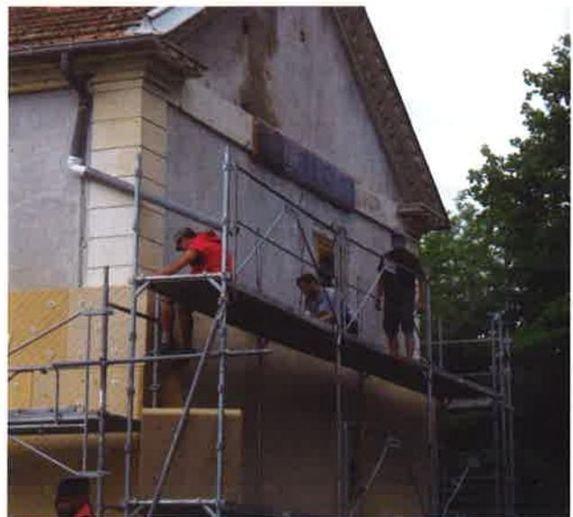
Isolation par l'extérieur en cours faisant disparaître chaînages et modénatures. DR
