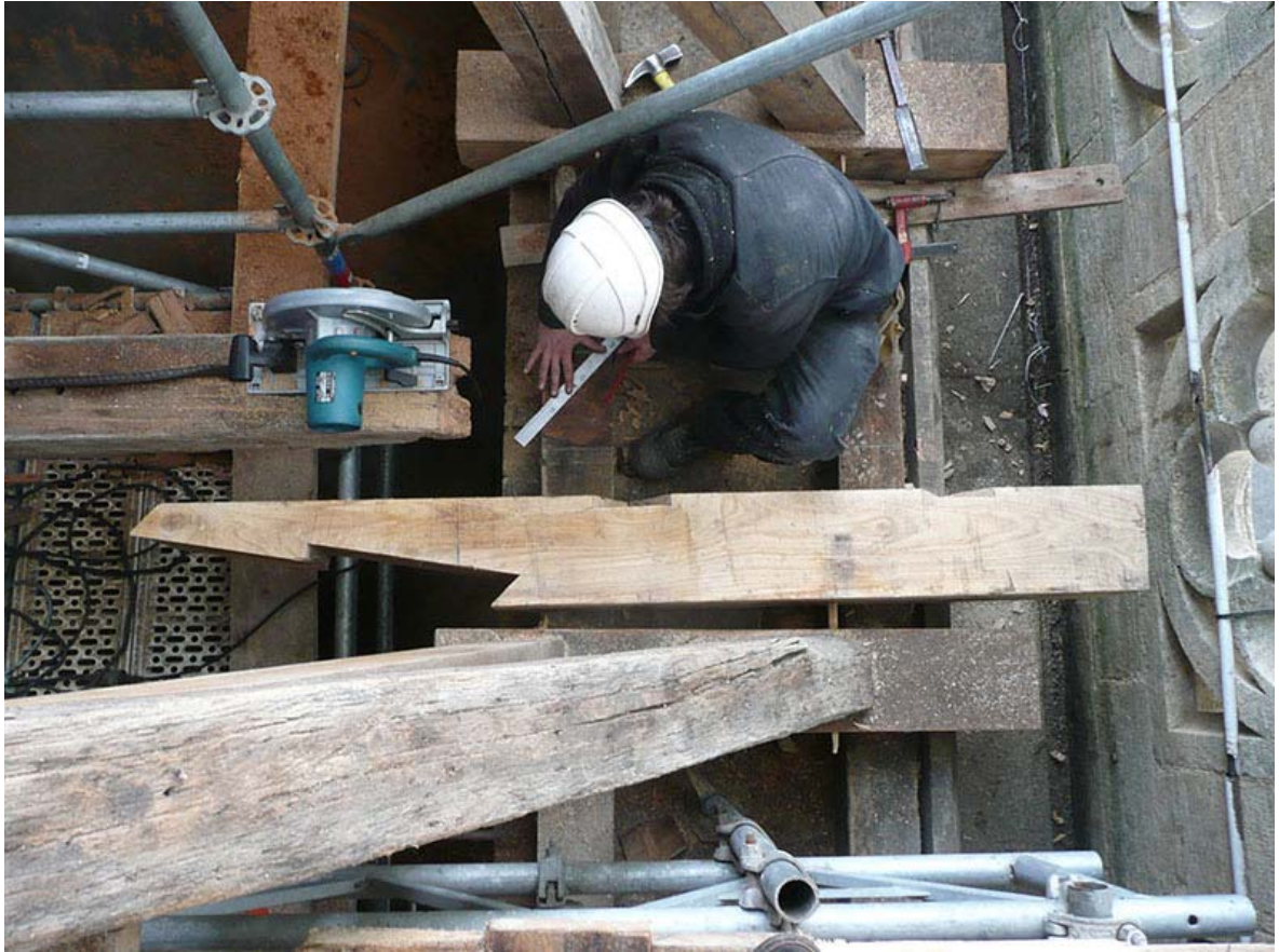
Ajustement d'une des entures des entrails (tracé du « chef Dominique », entreprise Les métiers du bois).
