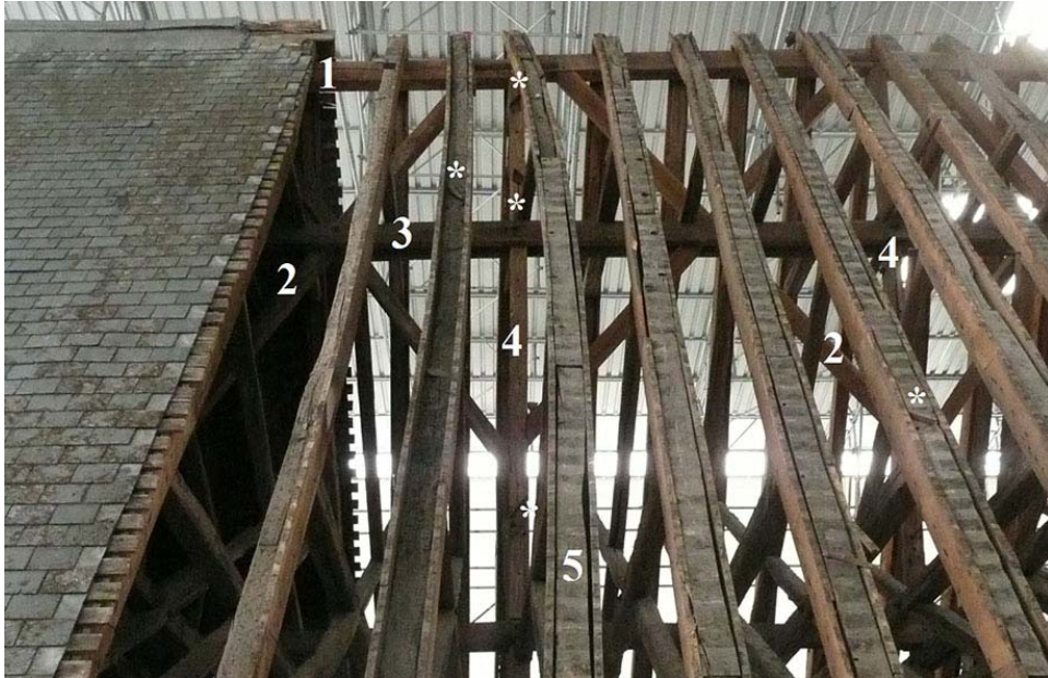
La charpente de la partie occidentale de la nef, après dépose des ardoises et des lattes. Légende : 1, 2 et 3 : ajouts d'un faitage, de croix de Saint-André et de moises longitudinales au XIXème siècle ; 4 : poinçon ; 5 : chevron moisé par côtés et fourré en réutilisant des parties de l'ancien contreventement médiéval) ; * : entailles de l'ancien contreventement visibles sur les poinçons et les faces extérieures des chevrons.
