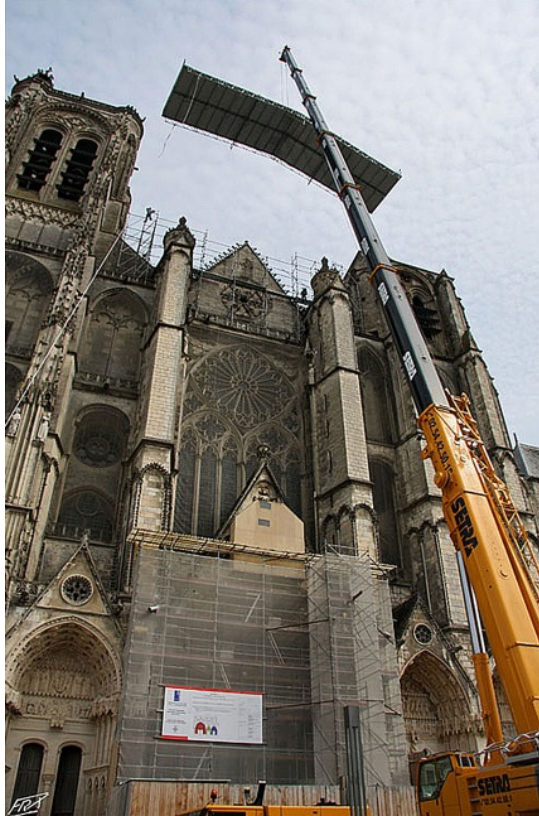
Pose du parapluie entre les tours (cl. Bruno Bornat, entreprise Comi service)
