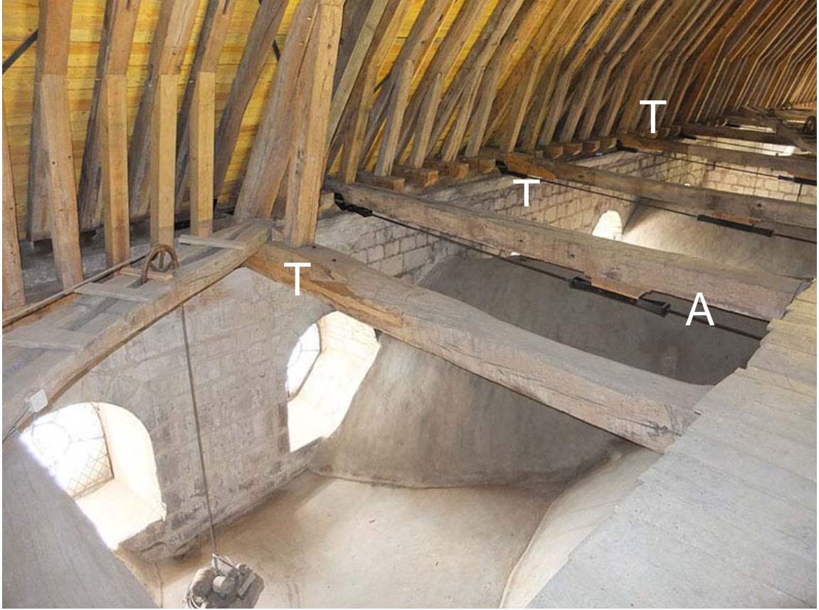
Vue des travaux terminés. Légende : A cantilever ; T entures des extrémités des entrails conservés.
