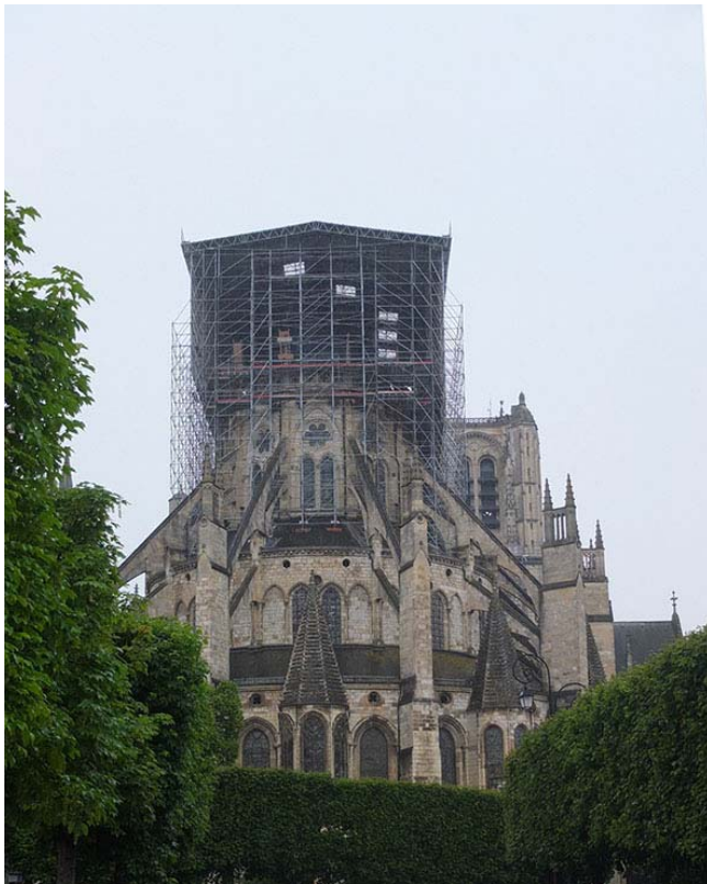
Mise en place du parapluie sur le chevet
