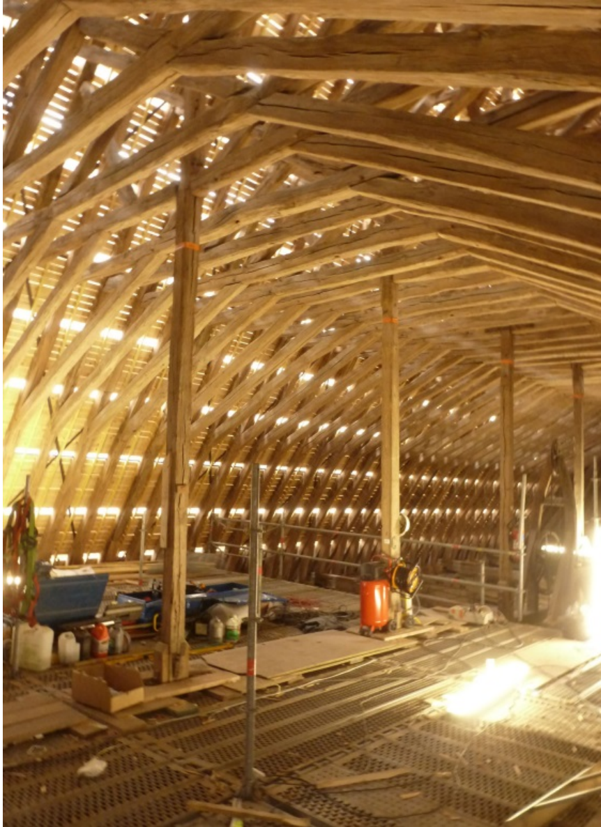
Vue générale du chantier de charpente : le plancher métallique reposant sur les murs permet de travailler en sécurité et de protéger les voûtes (38 m plus bas, le culte a été maintenu pendant toute la durée des travaux). Voligeage en cours : on aperçoit les contreventements métalliques solidarissant les chevrons entre eux.
