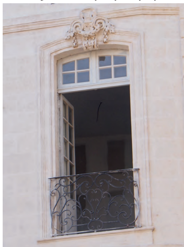
Réhabilitation intérieure d'un immeuble du XVIII e siècle du secteur sauvegardé de Bordeaux par emploi de « placoplâtre ».
