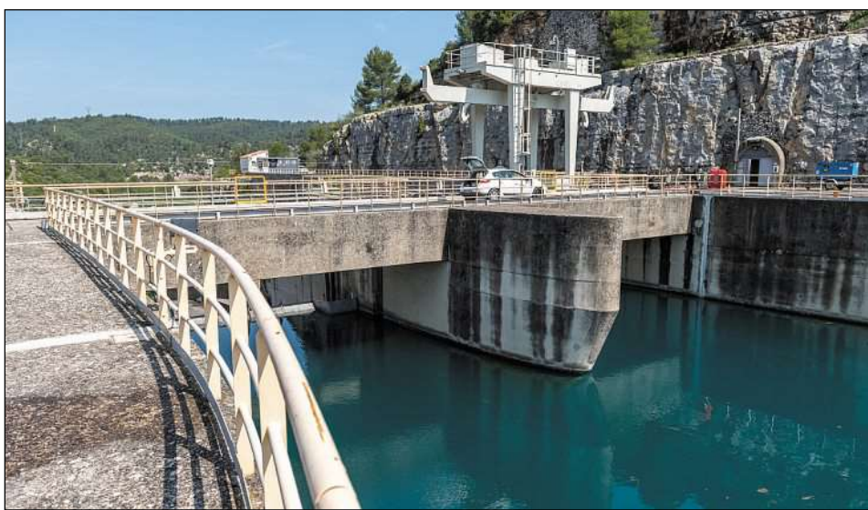
Les microcentrales hydroélectriques au fil de l'eau mieux acceptées que les grands barrages, comme ici à Vinon-sur-Verdon. (Photo Florian Escoffier)
